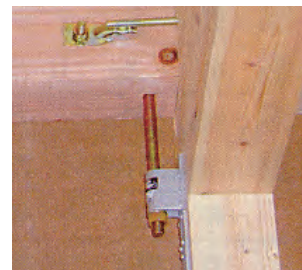
1、2階柱上部ホールダウン金物
